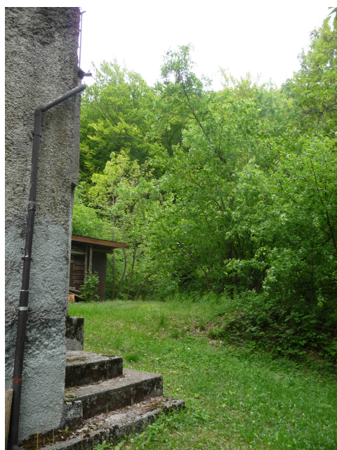
Foto dello spazio pertinenziali esterno
