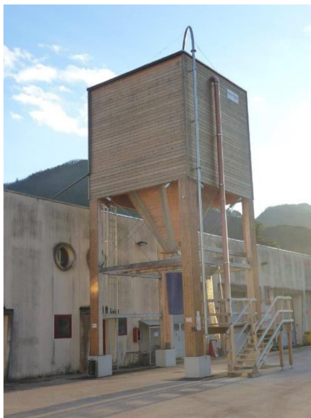
Figura 15: Silos per la distribuzione del sale a Borgo Valsugana
