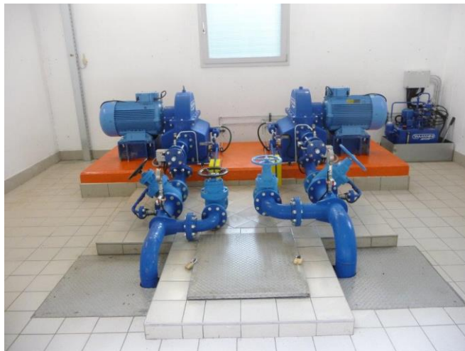
Figura 14: Nuova centralina "in Sella" composta da due mini turbine
